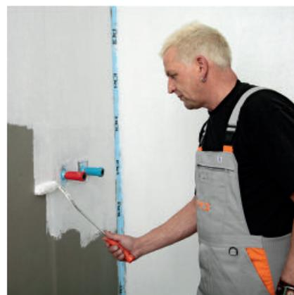
PCI Lastogum Klasse 2 wird unverdünnt durch Rollen, Streichen oder Spachteln auf den Untergrund aufgebracht.
