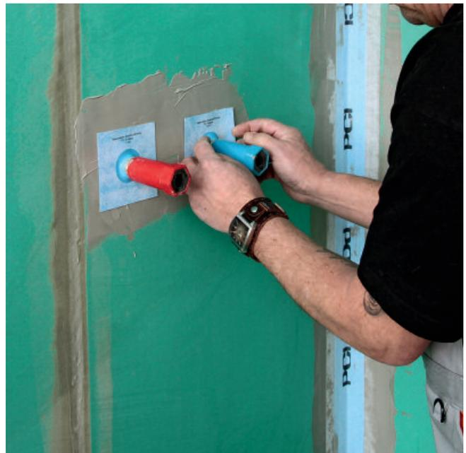
2. PCI Pectape 10 x 10 über den aus der Wand herausstehenden Rohranschluss stülpen und mit PCI Lastogum (grau) verkleben.
