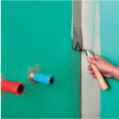
Vor dem Ausführen der Details (Wand- und Wand- Bodenanschlüsse) ausreichend viel Abdichtungsmaterial vorgelegt.
