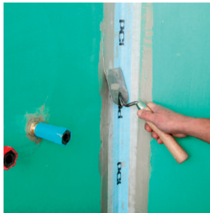
... und nachfolgend mit leichtem Druck eingebettet.
