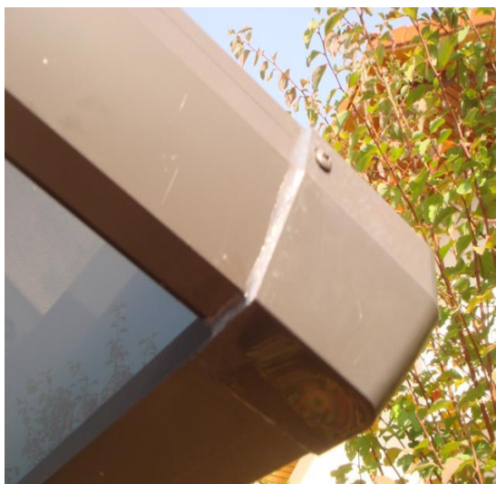
Bild 14: Montage und Abdichtung der Ecken
