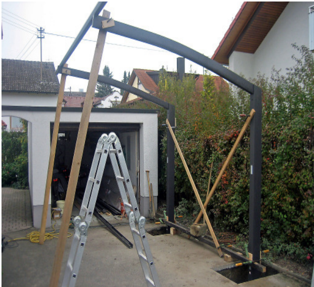
Bild 5 + 6: Beton einbringen und ca. 2 Tage aushärten lassen
