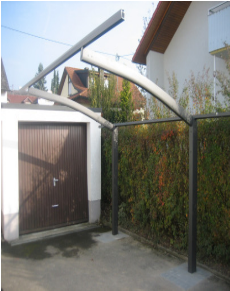
Bild 9 + 10: Montage der Querleisten
