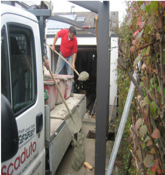
Bild 5 + 6: Beton einbringen und ca. 2 Tage aushärten lassen
