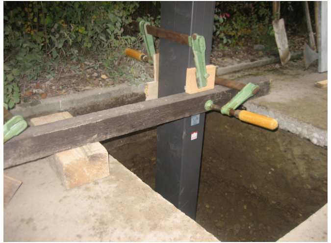
Bild 2: Positionieren der Bodenträger
