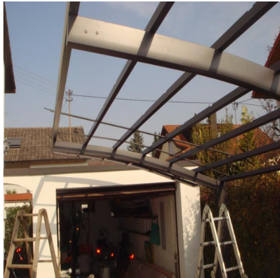
Bild 8: Montage der Längsleisten
