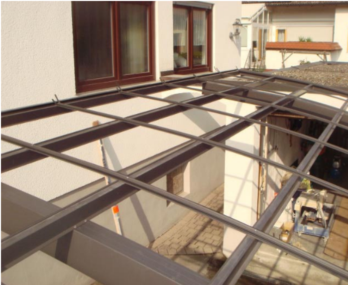
Bild 9 + 10: Montage der Querleisten
