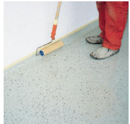
Der mit Farbchips abgestreute erste Auftrag von PCI Pursol 1K farblich muss mit PCI Pursol 1K transparent für einen dauerhaften Schutz nochmals überstrichen werden.
