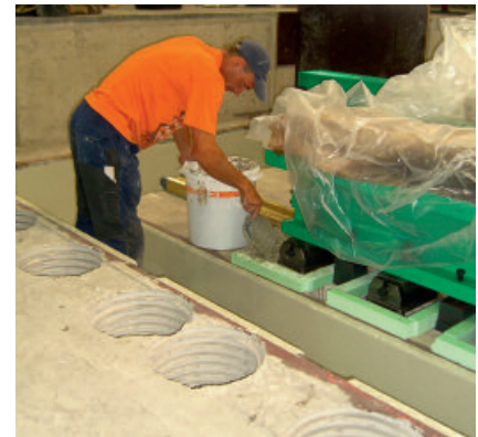
Verguss einer Maschinenverankerung mit PCI Repaflow Plus
