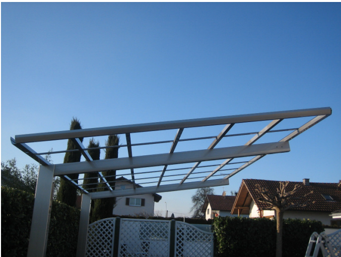
Bild 11: Montage der Querleisten
