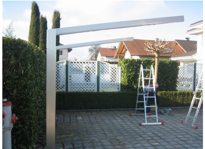
Bild 6: Montage der Dachträger
