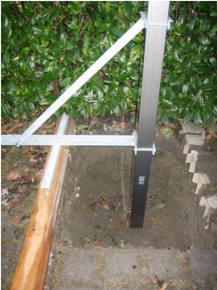
Bild 3 + 4: Beton einbringen und ca. 2 Tage aushärten lassen
