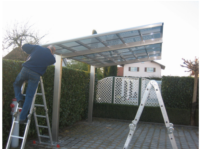
Bild 12: Montage der Abdeckungen
