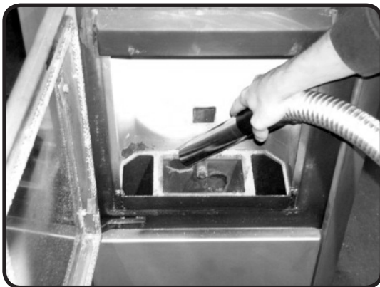
Abb. 14d: Reinigung der Topfhalterung
