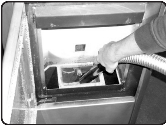
Abb. 14f: Reinigung Brennraumbehälter
