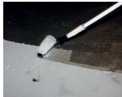
PCI Epoxigrund 390 bzw. PCI Epoxigrund Rapid wird in den vorbereiteten Untergrund z.B. mit einer Flächen/Malerwalze eingearbeitet.
