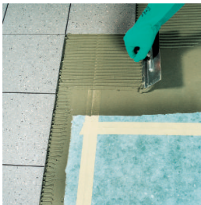
5. Anschließend keramische Beläge ohne Grundierung ...
