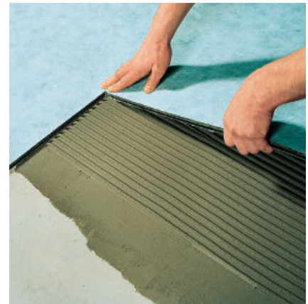
PCI Polysilent-Platten zur Trittschallminderung und zur Entkopplung von Keramik- und Naturwerksteinbelägen vom Untergrund.
