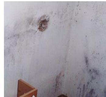
Punktförmige und Flächenwärmebrücken
