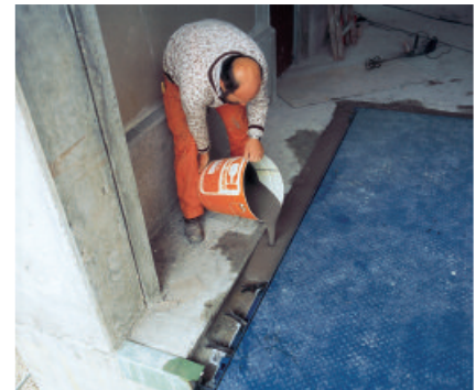
Kraftschlüssiger Verguss von Einbauteilen mit PCI Repaflow Turbo am Beispiel einer Laderampe.
