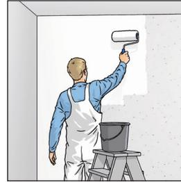
ERFURT-KlimaTec Systemkleber mit einer langflorigen Rolle in einer Breite von einer Bahn satt und gleichmäßig auf den Untergrund auftragen.
