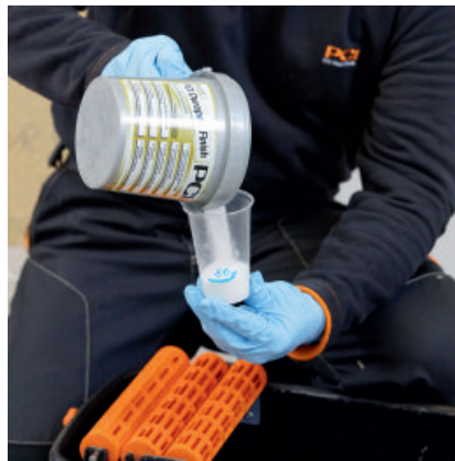
Hinzumischen von PCI Durapox Finish (Konzentrat) in das Waschwasser. Mischungsverhältnis 1 : 100
