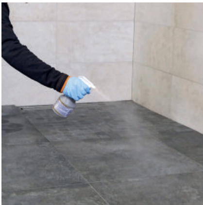
Aufsprühen von PCI Durapox Finish (Flüssig) vor dem finalen Waschgang
