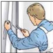
**6.** In Ecken und an Kanten Tapetenbahn abschneiden und nachfolgende Bahn auf Stoß tapezieren
