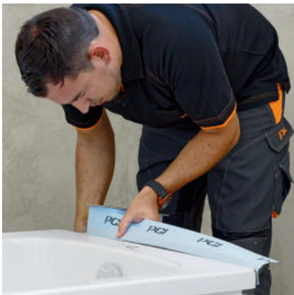
Schutzfolie abziehen und das PCI Pecitape WDB ohne Spannung mit Schaumoberkante an den Wannenrand ankleben.
