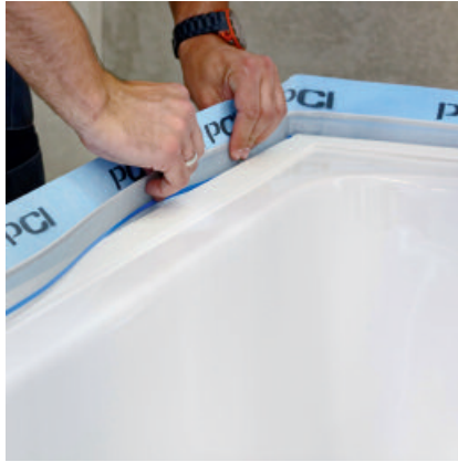
Optional kann das Schnittschutzband PCI Pecitape Protect in die vorgefertigte Tasche von PCI Pecitape WDB eingelegt werden.
