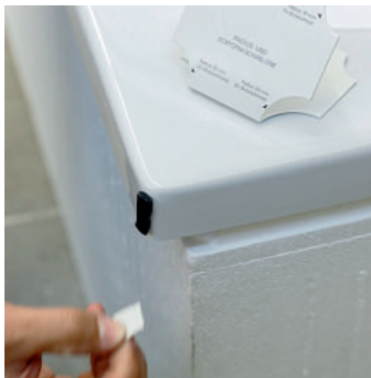
Nach Bestimmung des Wannenradius mittels der Schablone, ein oder mehrere Eckfüllstoffe ansetzen.
