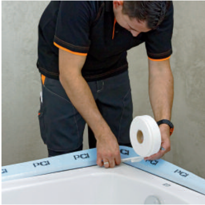
Distanzband ablängen und bündig zum Wannenrand anstoßend einbringen.
