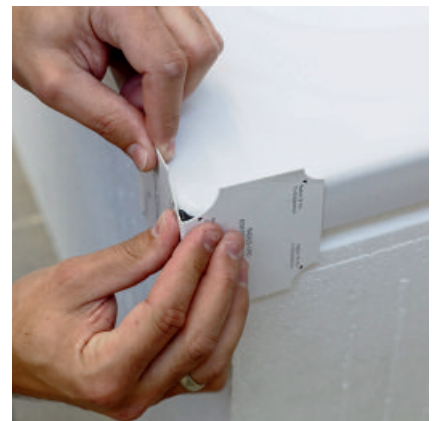
Mit Hilfe der wachsbeschichteten Schablone zu einem rechten Winkel modellieren.
