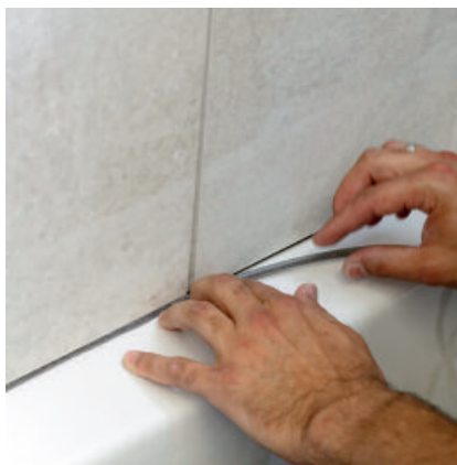
Rundschnur einlegen und anschließend Silikonfuge einbringen.
