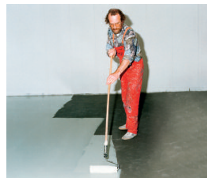
Die Epoxi-Versiegelung PCI Apokor W lässt sich leicht und ohne Belastung der Umwelt und des Verarbeiters durch Lösemitteldämpfe verarbeiten.
