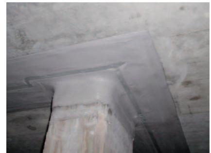
PCI Pecitape 3000 - Abdichtungsband mit PCI Barrafix EP verklebt.
