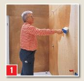
Saugfähige Untergründe, z.B. Spanplatten, mit BESTE BASIS grundieren.
