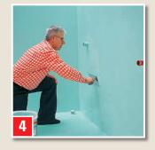
Nach frühestens 6 Stunden 2. Schicht aufbringen. Hier alternativ der Auftrag mit der Glättkelle. Fliesen frühestens nach 18 Stunden kleben.
