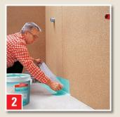
In den Eckfugen DICHTUNGS-BAND in die frische erste Schicht DUSCHABDICHTUNG einbetten.
