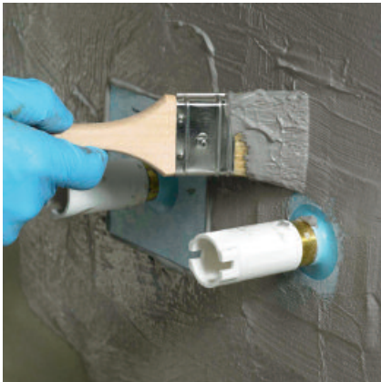
Die Dichtmanschetten PCI Pecitape 10 x 10 ordnungsgemäß einbetten.
