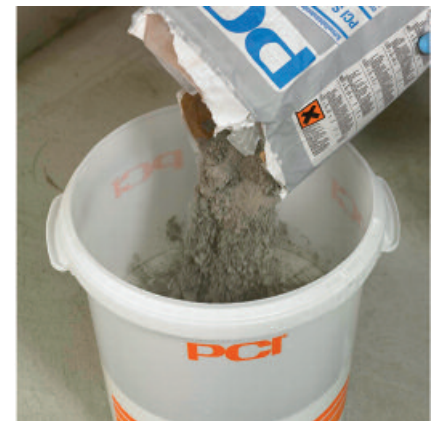
PCI Seccoral 2K Rapid Pulver dazugeben.
