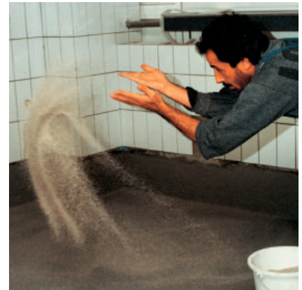
... und Quarzsand (Körnung 0,3 bis 0,8 mm) in die frische Beschichtung eingestreut.
