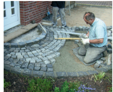
Verlegen von Kleinpflaster in PCI Pavifix DM.
