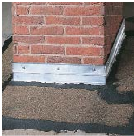
Kappteile am Schornstein mit SCHWARZER BLOCKER SPACHELMASSE und Bitumenbahn abgedichtet.
