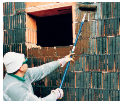
PCI Pecimor F, 1 : 5 mit Wasser verdünnt, als Grundierung für eine Bauwerksabdichtung mit kunststoffmodifizierter Bitumendickbeschichtung nach DIN 18 195.
