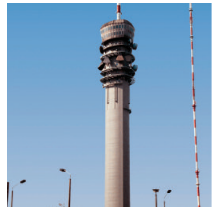
Dauerhafter Schutz durch den rissüberbrückenden Elastischem Oberflächenschutz PCI Polyflex.
