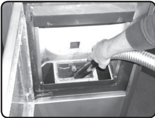
Abb. 14f: Reinigung Brennraumbehälter
