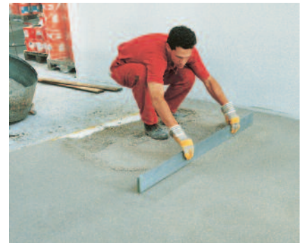
Einbau eines hochverschleißfesten und chemikalienbeständigen Industrieestrichs mit PCI Bauharz-Mörtel.
