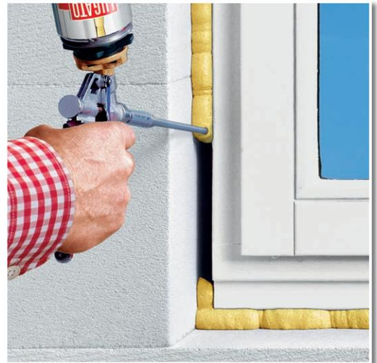
In Verbindung mit der BAUSCHAUM-PISTOLE: exaktes Dosieren von PISTOLENSCHAUM.
