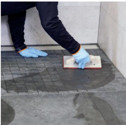
PCI Durapox Premium mit einer Hartgummifug-scheibe in die Fugen einbringen.
