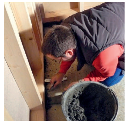
Unterstopfen von Holzrahmen mit PCI Repaflow USM um einen kraftschlüssigen Verbund zur Bodenplatte herzustellen.
