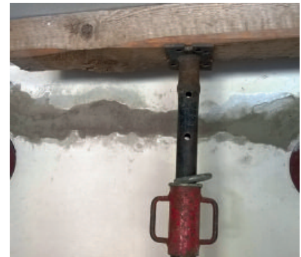
Unterstopfen eines Schlitzes in einer tragenden Wand mit PCI Repaflow USM.
